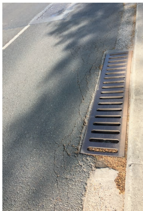
–Photos 2 et 3– Dégradations autour des émergences.
